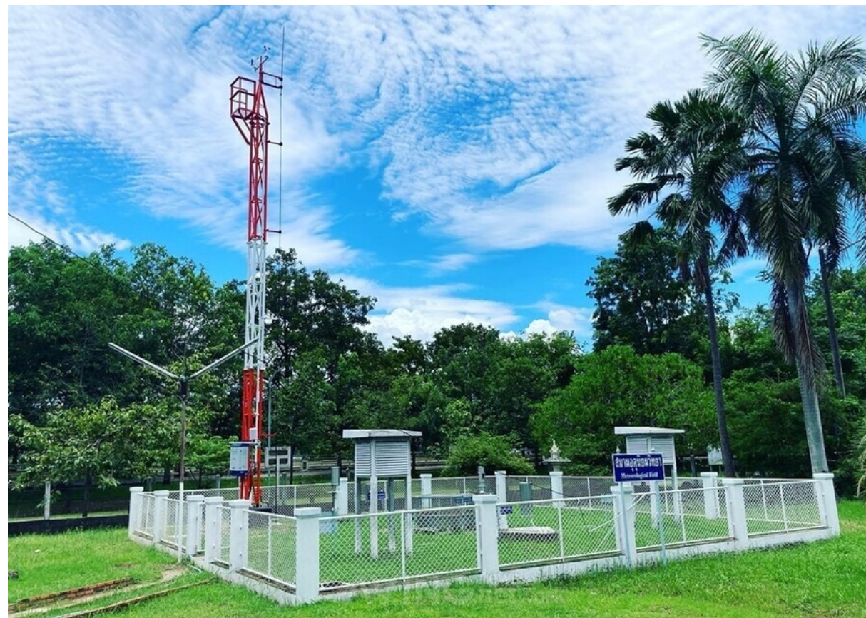
자동기상관측시스템(AWS) 설치 예시
